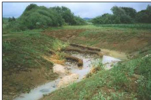
**Abb. 8.4: Kokosfaschinen zur Filterung von Nährstoffen (Quelle: E+E-Renaturierungsprojekt, WWA Bayreuth)**
