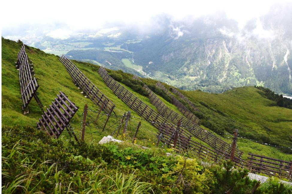
Abbildung 13: Lawinerverbauungen an der Ostseite des Söllerkopfs (Foto: M. Wecker)
