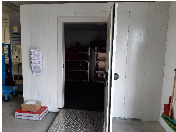
Abbildung 10: Kühlzelle mit Tür zur Be- und Entladung.
