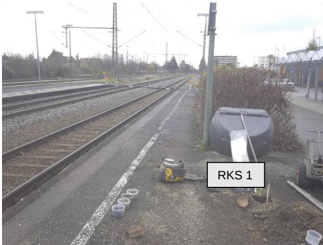
Bild 1: Bereich RKS 1, Blick nach Osten
