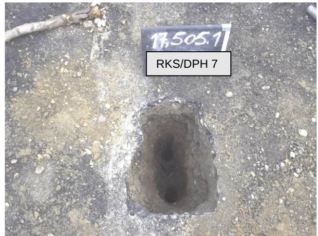
Bild 14: Aufbruch bei RKS/DPH 7
