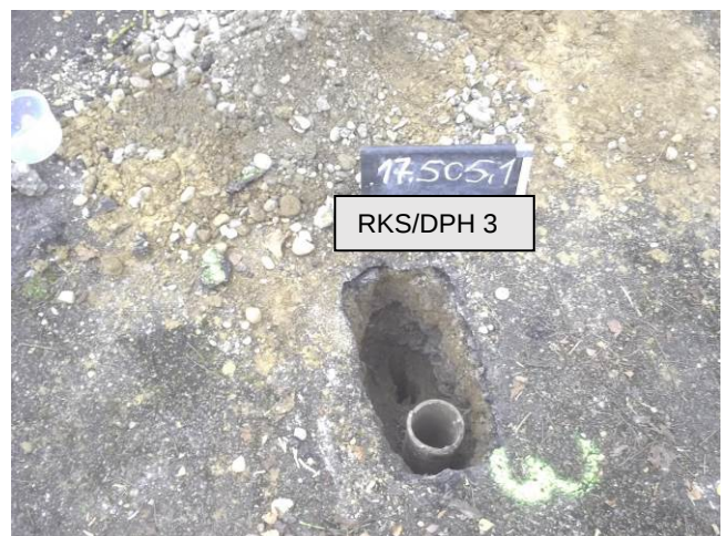
Bild 6: Aufbruch bei RKS/DPH 3
