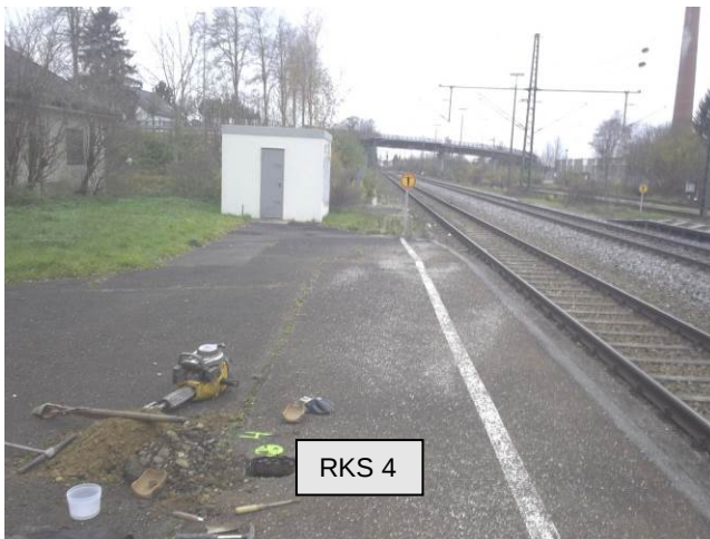
Bild 7: Bereich RKS 4, Blick nach Westen
