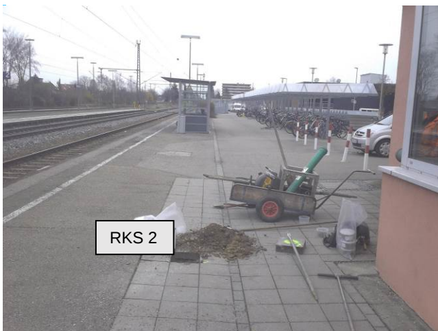
Bild 3: Bereich RKS 2, Blick nach Osten
