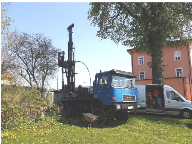
Bild 17: Ausführung BK 1, Blick nach NO
