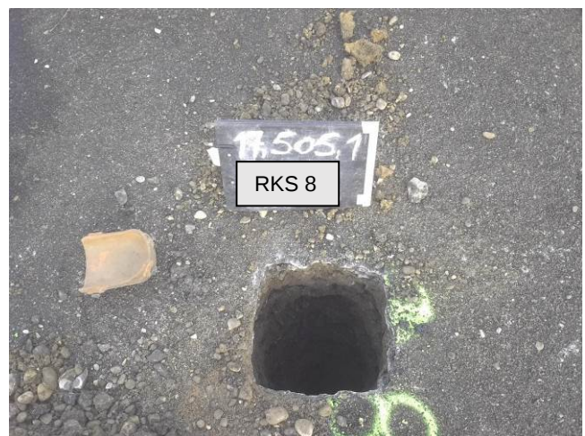
Bild 16: Aufbruch bei RKS 8
