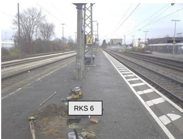
Bild 11: Bereich RKS 6, Blick nach Osten
