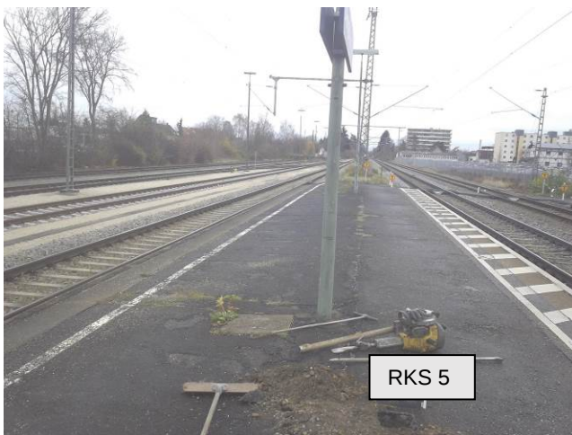
Bild 9: Bereich RKS 5, Blick nach Osten
