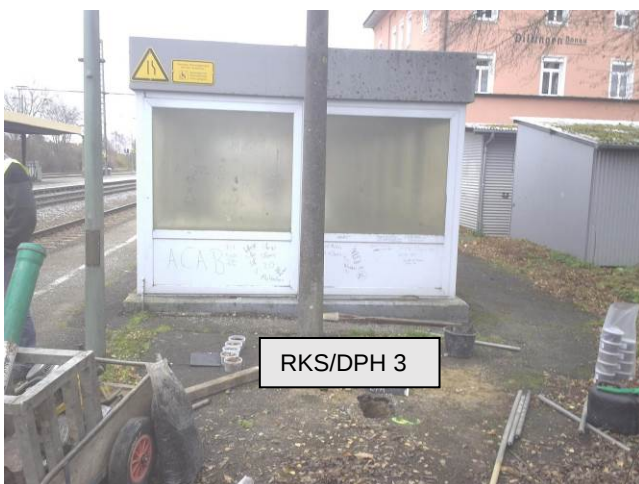
Bild 5: Bereich RKS/DPH 3, Blick nach Osten
