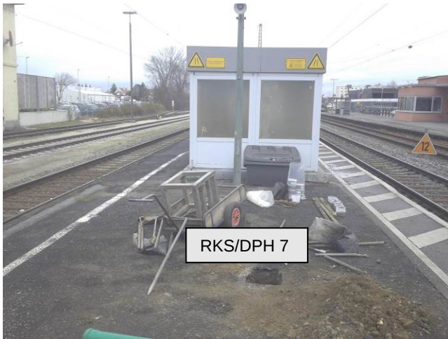
Bild 13: Bereich RKS/DPH 7, Blick nach Osten
