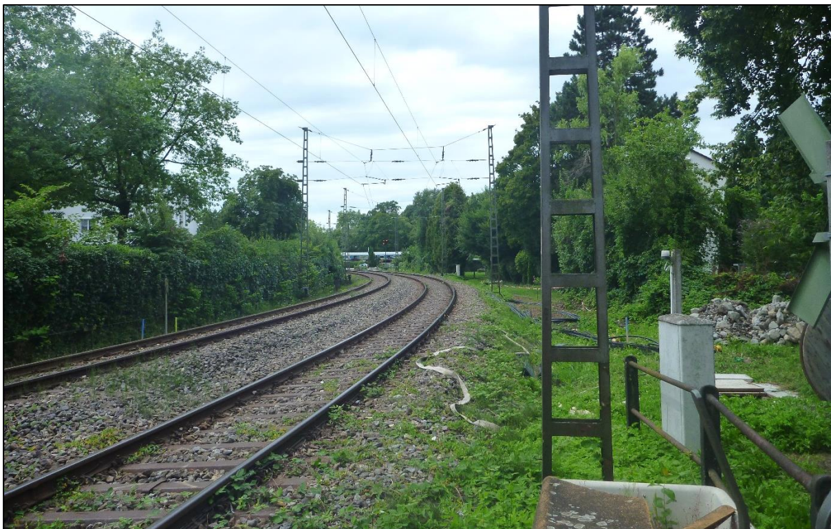
Abbildung 5: Gleisbereich westlich des BÜ mit angrenzenden Ruderalflächen sowie Gehölzstrukturen und Einzelbäumen; Blick Richtung Westen (Foto: AFRY Deutschland GmbH, 2019)
