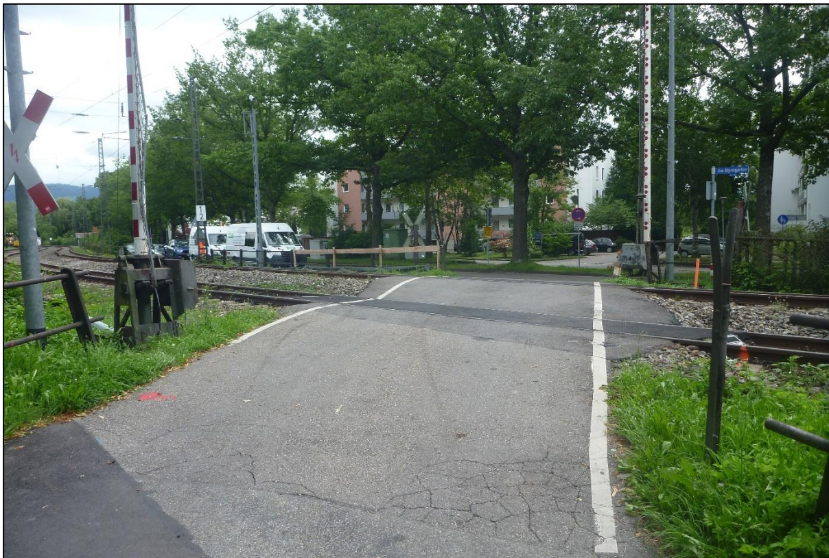
Abbildung 4: Blick auf den BÜ Hasenweidweg Ost, Blick Richtung Süden (Foto: AFRY Deutschland GmbH, 2019)
