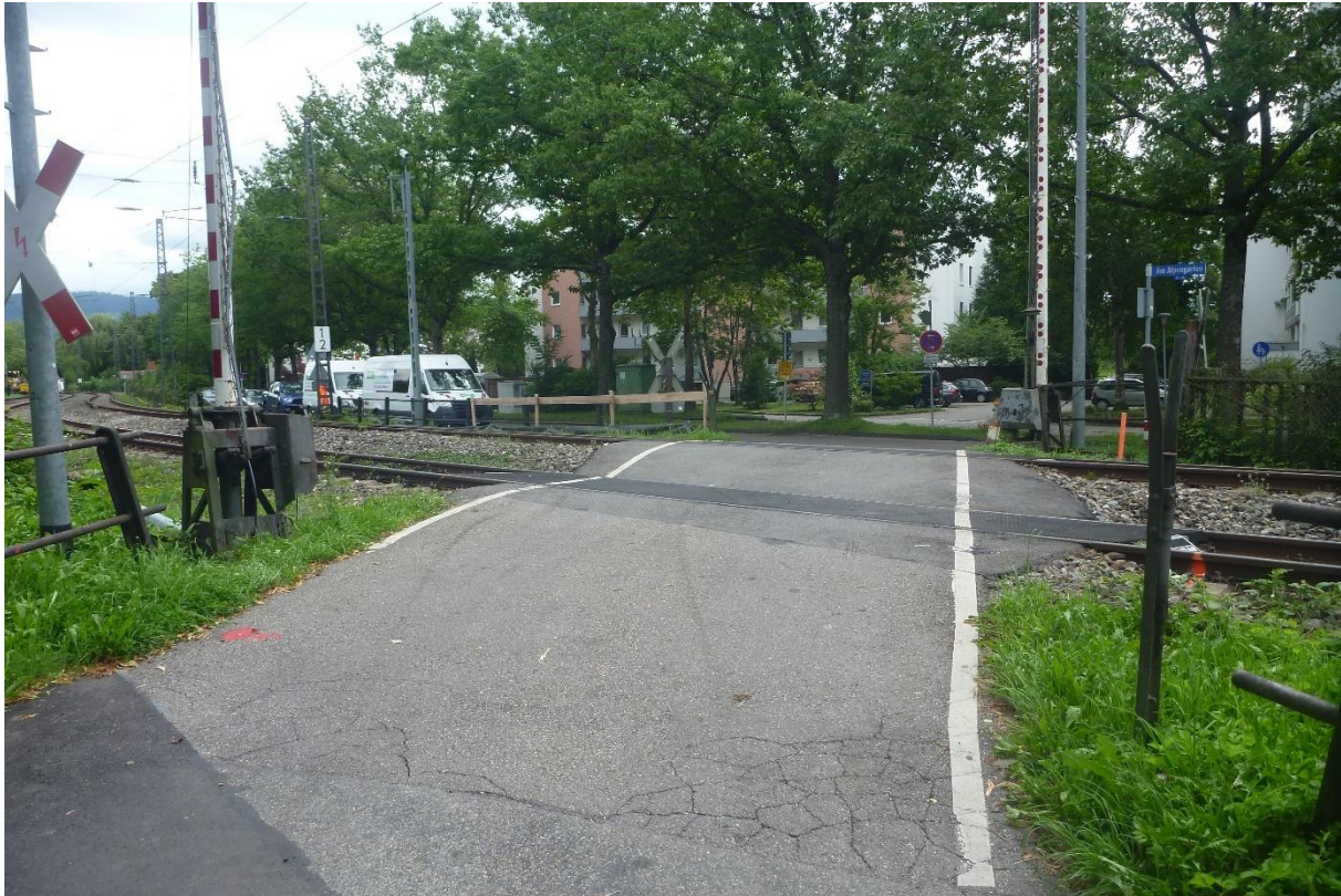
Abbildung 2: Blick auf den BÜ Hasenweidweg Ost, Blick Richtung Süden (Foto: AFRY Deutschland GmbH, 2019)
