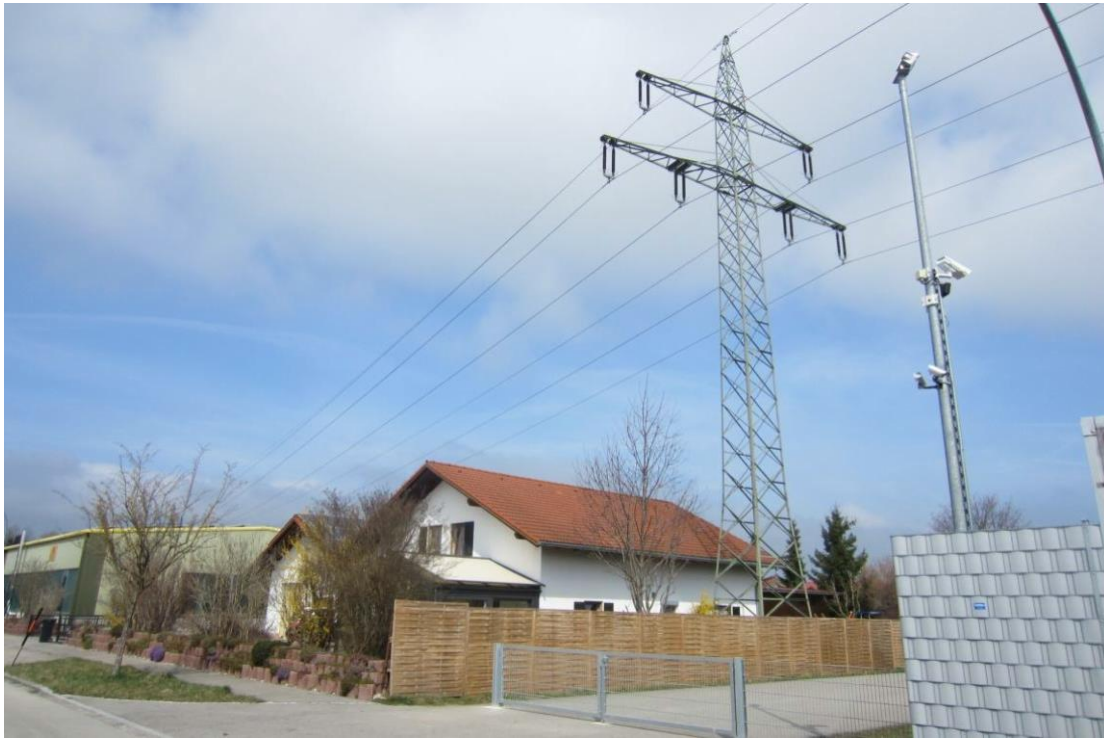
Abbildung 1: Betriebsleiter Wohnhaus im Gewerbegebiet Marktoberdorf mit bestehendem Mast Nr. 111/24
