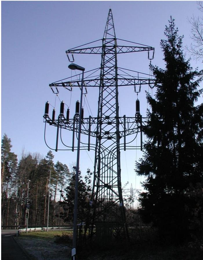
**Abbildung 10:** Beispiel eines Übergangsmastes mit Kabelendverschlüssen
