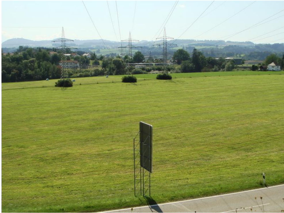
Foto 5 Trassenabschnitt zwischen St 2377 und Iller, Blickrichtung Südwest, 25.08.2019: Südlich Straße Intensivgrünland, in der Bildmitte Maststandort 2 (mittlerer Mast) zwischen zwei weiteren, parallel verlaufenden Trassen, im Hintergrund E-Werk bei Krugzell
