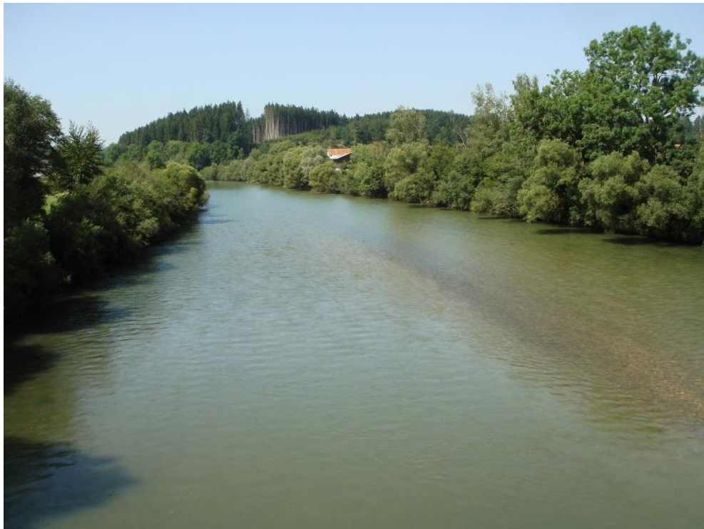
Foto 12 Iller bei Krugzell westlich Brücke der St 2377, Blickrichtung West, 25.08.2019: Im Vordergrund rechts bei Niedrigwasser freiliegende Kiesbank (vgl. Karte 1), Ufer beidseitig mit durchgehendem Gehölzsaum, dahinter Grünland, im Hintergrund Fichtenhochwald auf Höhenrücken westlich Schwarzenbach
