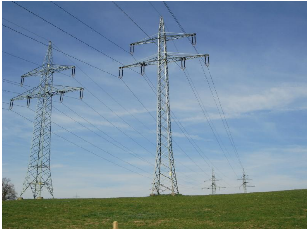
Foto 6 Trassenabschnitt nördlich St 2377, Blickrichtung Nord, 6.04.2019: Intensivgrünland mit Maststandort 3 (vorne) und 4 (jeweils rechts) neben parallel verlaufender Trasse im Südwesten von Dietmannsried
