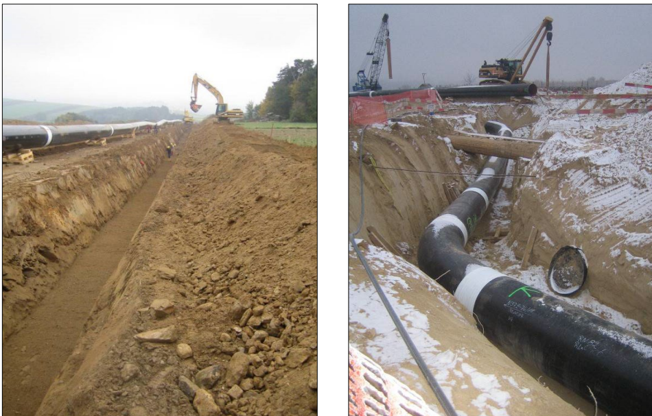
Abbildung 21 Erstellung des Rohrgrabens und Unterquerung von Fremdleitungen
