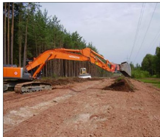
Abbildung 26 Rekultivierung: Schaffung eines Planums und Wiederauftrag des Oberbodens
