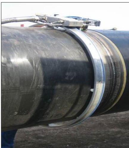
Abbildung 20 Prüfen der Schweißnähte mittels Ultraschall- / Durchstrahlungsprüfung
