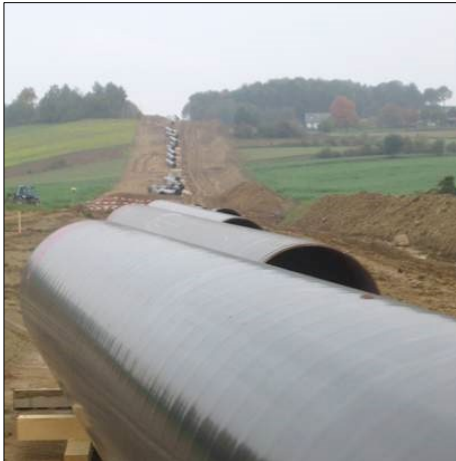
Abbildung 19 Ausgelegte Rohre auf dem Arbeitsstreifen
