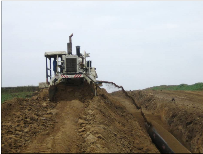
Abbildung 24 Verfüllen des Rohrgrabens
