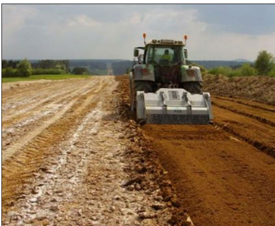
Abbildung 26 Rekultivierung: Schaffung eines Planums und Wiederauftrag des Oberbodens
