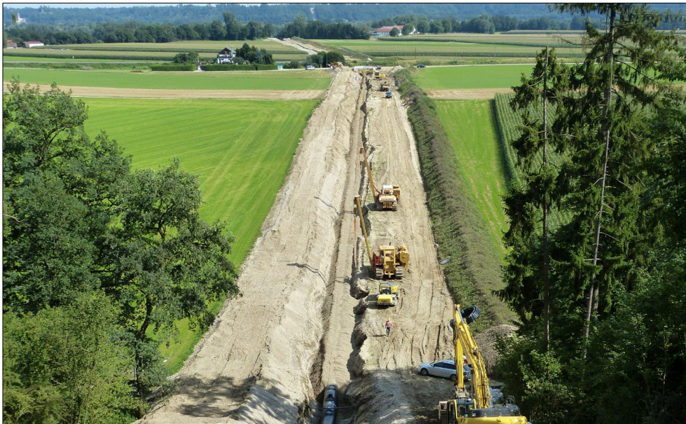
Abbildung 25 Übersicht Arbeitsstreifen und Verfüllen des Rohrgrabens
