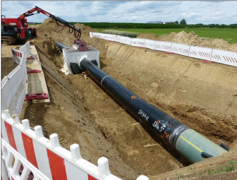
Abbildung 23 Verschweißen der Rohrstränge im Rohrgraben
