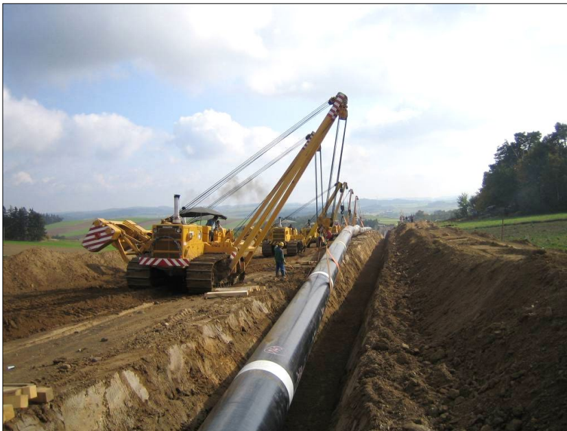
Abbildung 22 Absenken des Rohrstrangs mit Seitenbaumraupen
