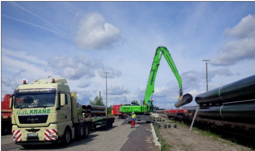
Abbildung 18 Verladen der Rohre
