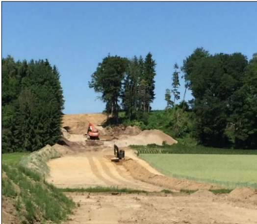
Abbildung 17 Trassenvorbereitung, Oberbodenabtrag
