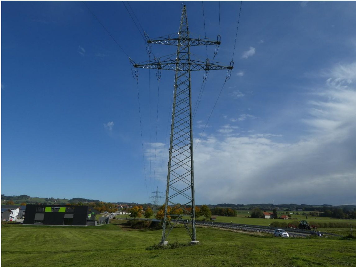
Abbildung 2: Ende des Planfeststellungsabschnittes am Mast Nr. 9 (Anlage 66001) 4
