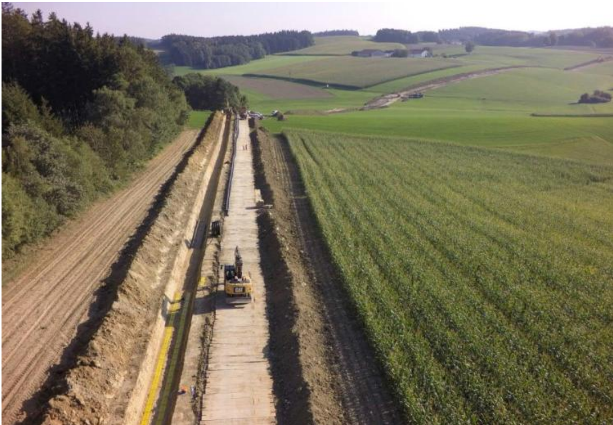
Abbildung 2: Kabelverlegung in offener Bauweise
