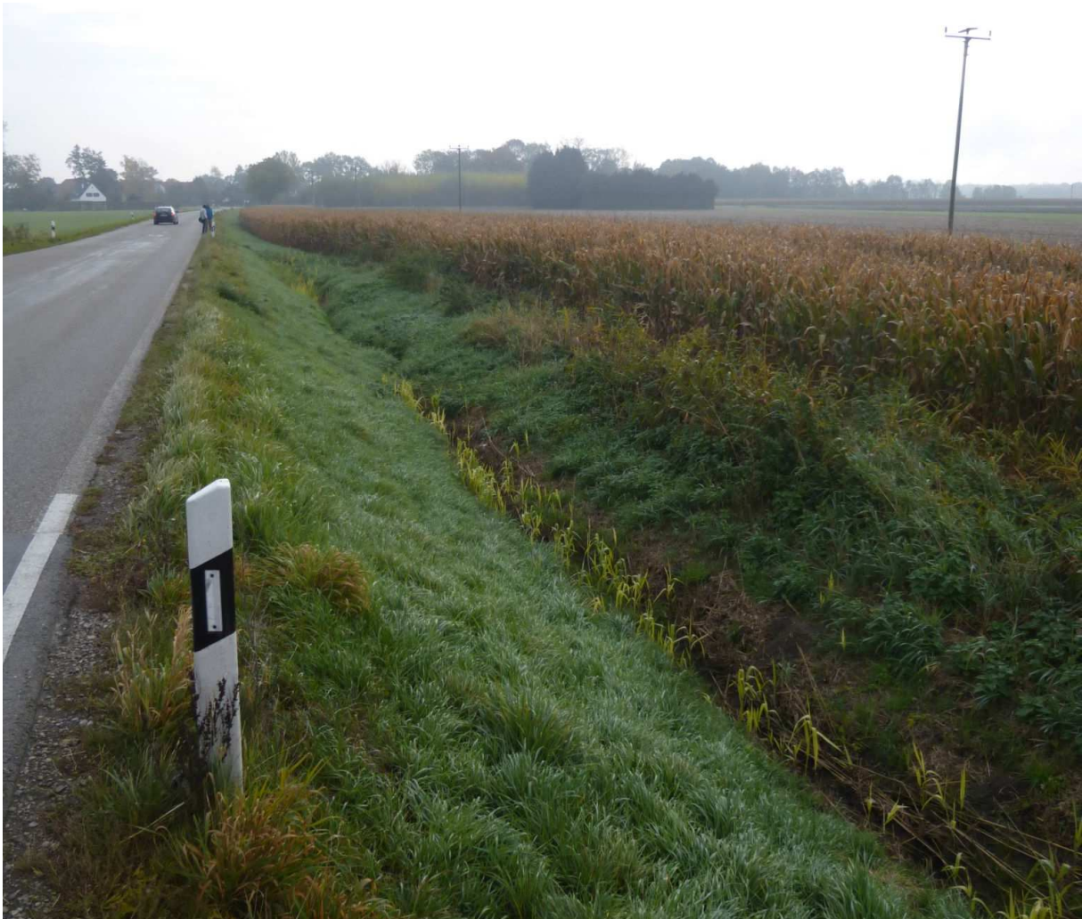
Abbildung 6: Bestandssituation des Moosgraben; Blick nach Osten
