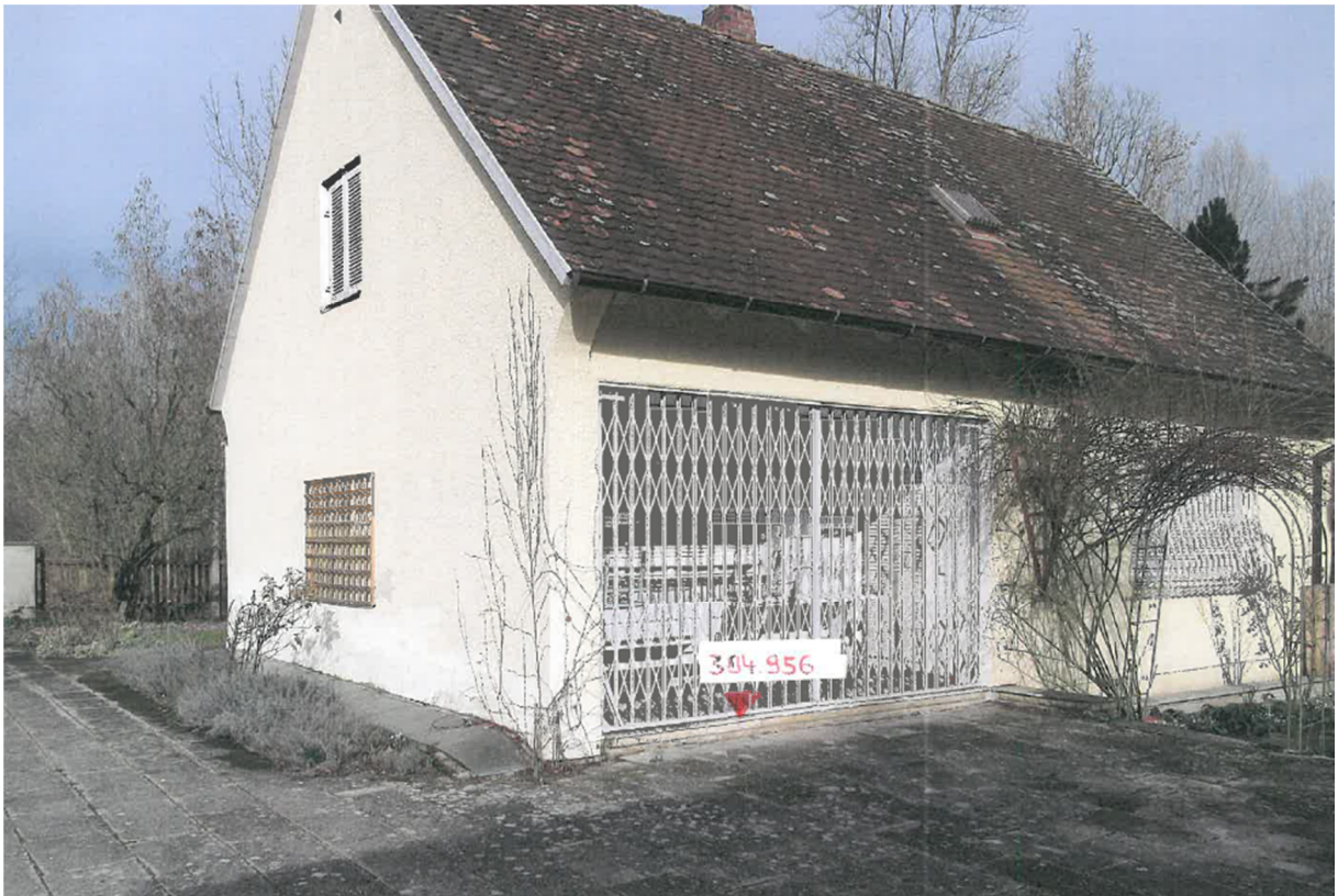
Abbildung 10: Gebäude Zollhäuschen, niedrigste Schwellenhöhe 394.95 m ü. NHN
