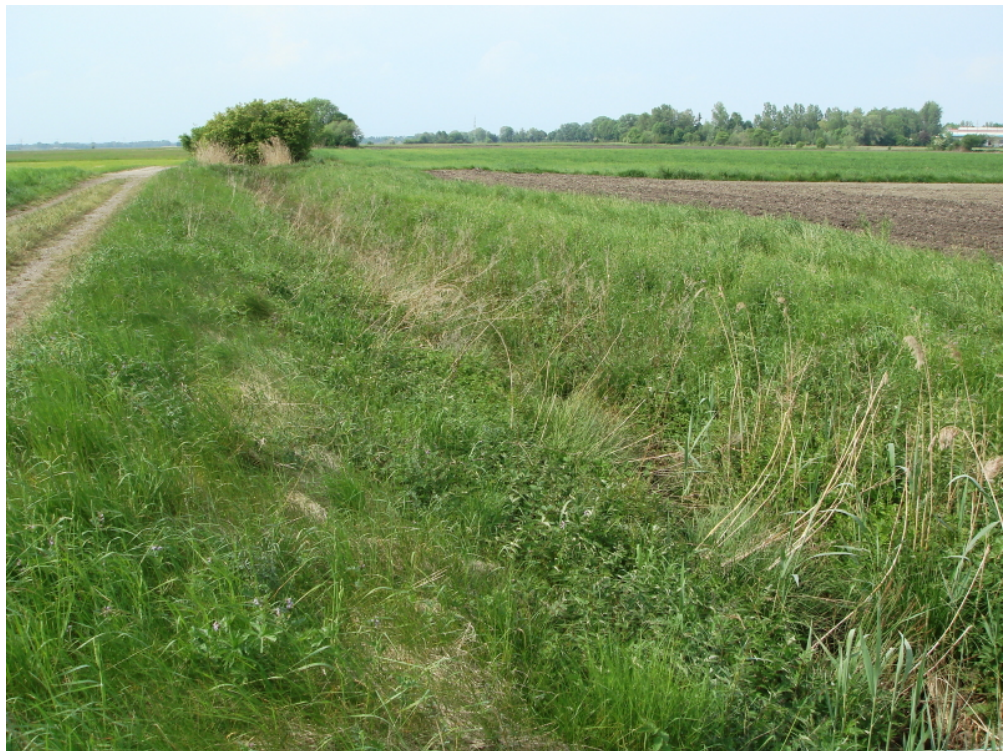
Foto 12 Schwarzgraben im Norden des Campingplatzes, Blickrichtung Nord: Offener, besonderer Abschnitt, Graben eingewachsen
