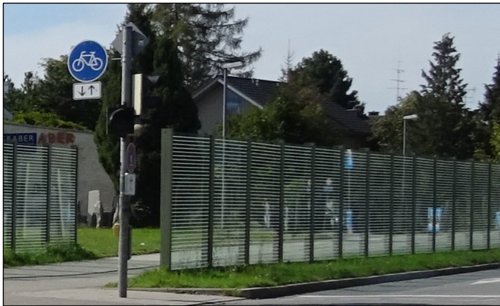
Abb. 9: Beispiel für eine markierte Glas-Lärmschutzwand, hier aus München.
