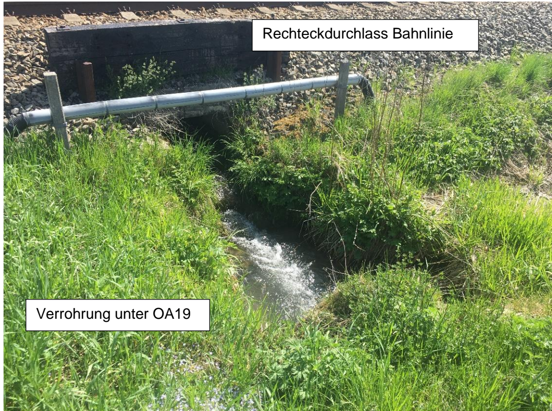
Abbildung 3-4: Ende Bahndurchlass und Beginn Verrohrung unter der Straße OA19 [Quelle: WipflerPLAN]
