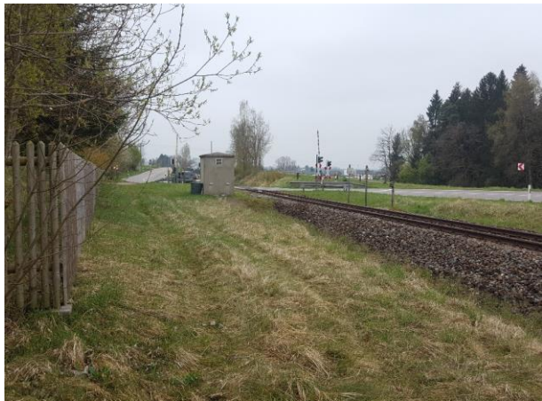
Abb.3: Kreisstraße OA 19, Bahnübergang bei Oberbühlers
