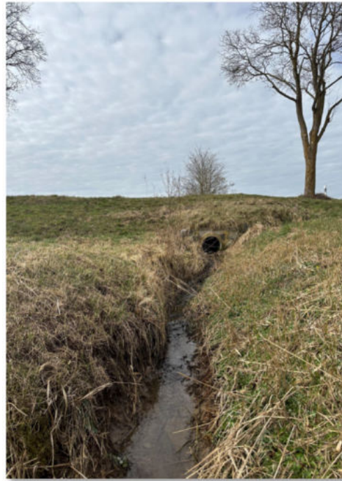
Abb. 20: Krautgertgraben unterhalb Auslauf
