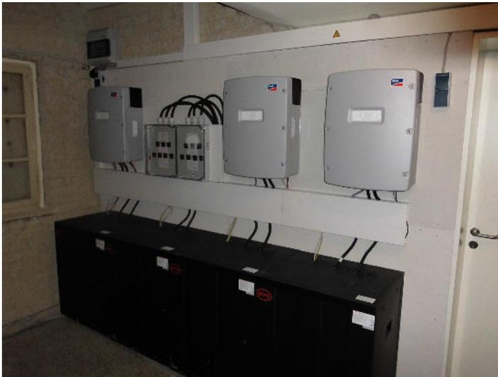
Kombipaket besteht aus 4 Batterien mit Lithium Eisenphosphat und 3 SMA WR, modularer Aufbau mit patentiertem Steckersystem
