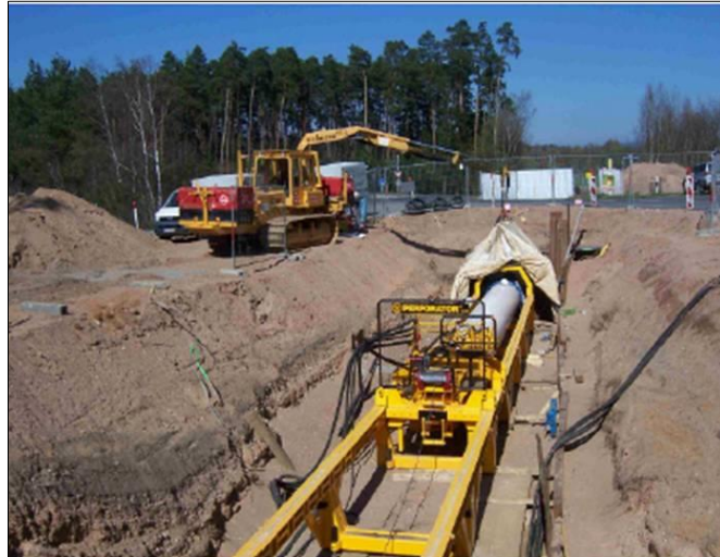
Abbildung 20: Horizontal-Bohr- / Pressverfahren
