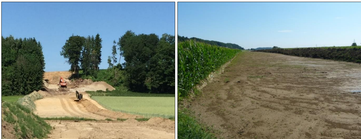
Abbildung 15: Trassenvorbereitung, Oberbodenabtrag
