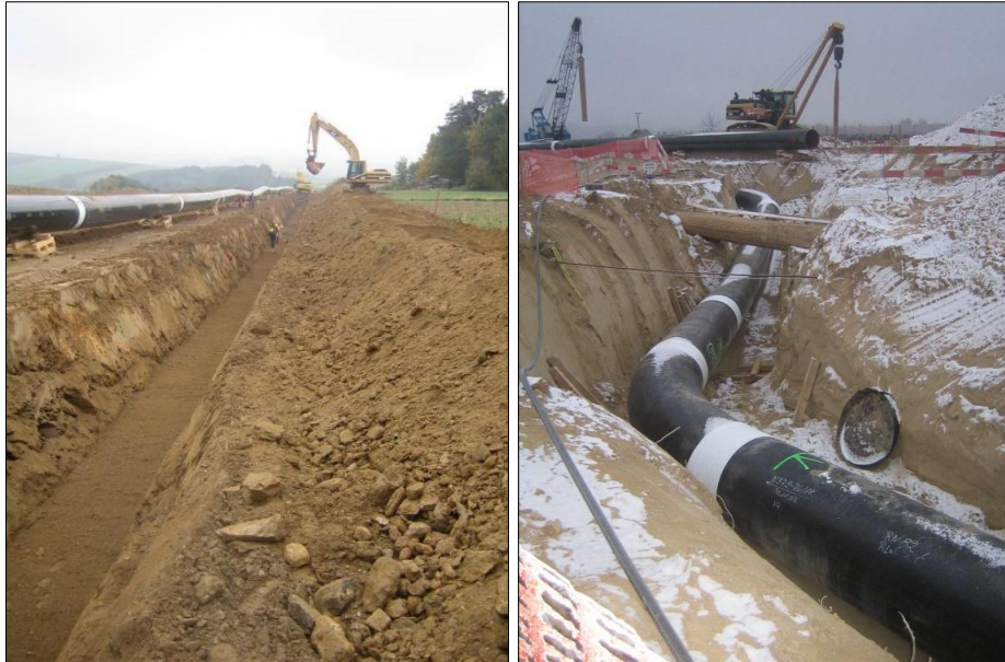
Abbildung 19: Erstellung des Rohrgrabens und Unterquerung von Fremdleitungen
