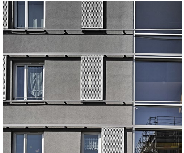
Fassade mit verschiebbaren Verschattungselementen
